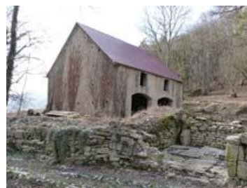
Février 2012 : les échafaudages sont démontés
