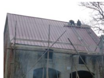
05 Décembre 2011 : la couverture est achevée
