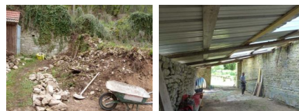
Le hangar : Une réalisation d'importance !
