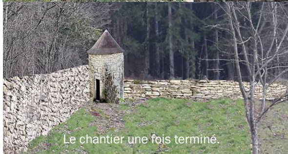
Michel et son chantier Janvier 2020
