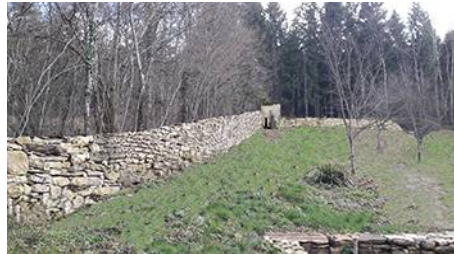
Le chantier au 01/04/2020
