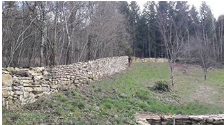
Le chantier au 01/02/2020
