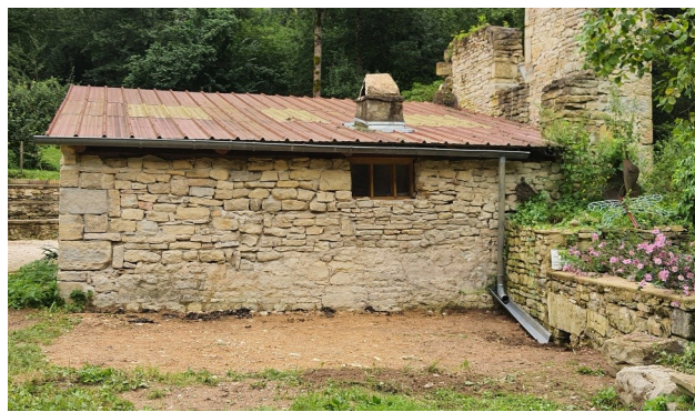
La mare est comblée, la descente d'eau déplacée.
